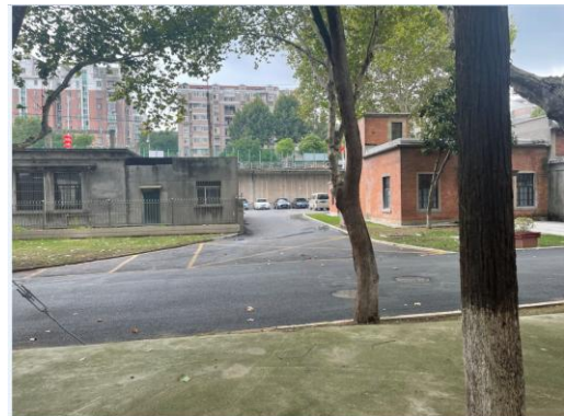
改建 CT 探伤室南侧
